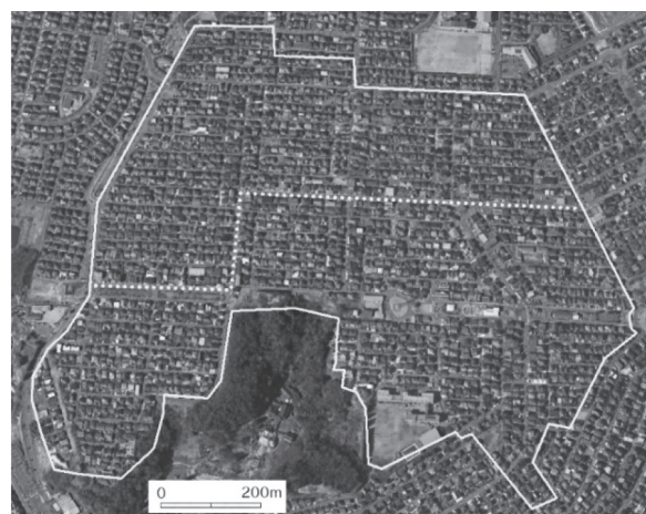
画像1 向陽台（Google Earth, 2017） 実線：向陽台の範囲、点線：商店が並ぶメイン街路、 中央下の森は古利・洞雲寺（山の寺）
